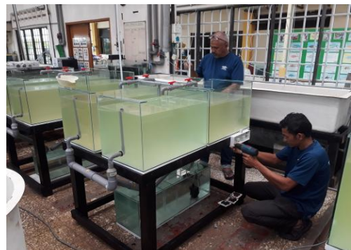
Pemasangan sistem bekalan elektrik bagi kegunaan pam sistem penapis
