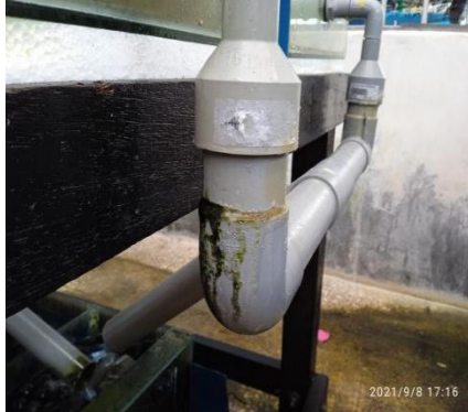
Memastikan tiada kebocoran pada sistem pempaipan
