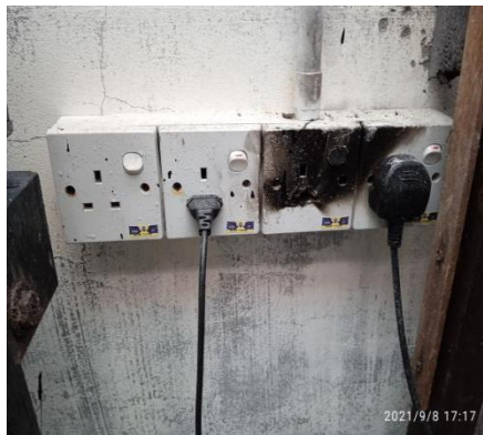
Menukar suis elektrik yang rosak, terbakar dan lain-lain
