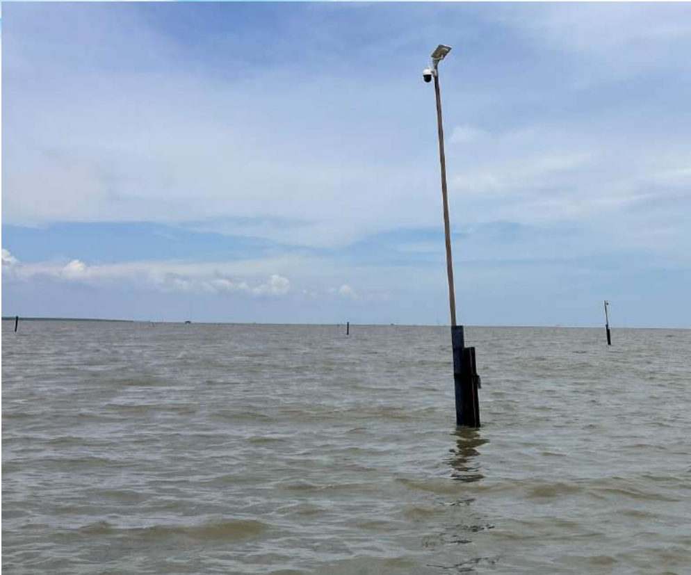
Gambar 67: Penggunaan Kamera Litar Tertutup (CCTV) di lokasi lot Kerang.
