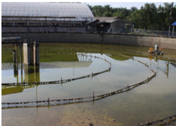
Gambar 11: Proses Pengeringan Kolam
