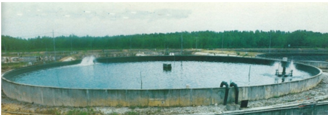
Gambar 8: Kolam bulat berdinding konkrit.
