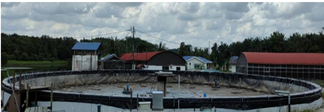
Gambar 9: Kolam bulat berdinding konkrit dasar plastik.
