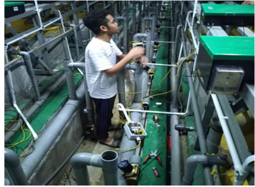
Pemasangan injap ECV dan sistem kawalan berkomputer pembuangan air kumbahan dari CENTS-RAS
