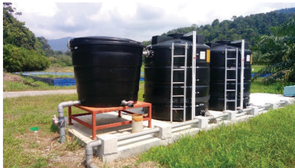
Gambar 3.1: Tangki rawatan air dari sumber sungai di kemudahan ternakan Moina sp. sistem terbuka
