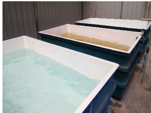
Gambar 3.4b: Sumber air domestik (kiri) dan sumber air sungai (kanan).
