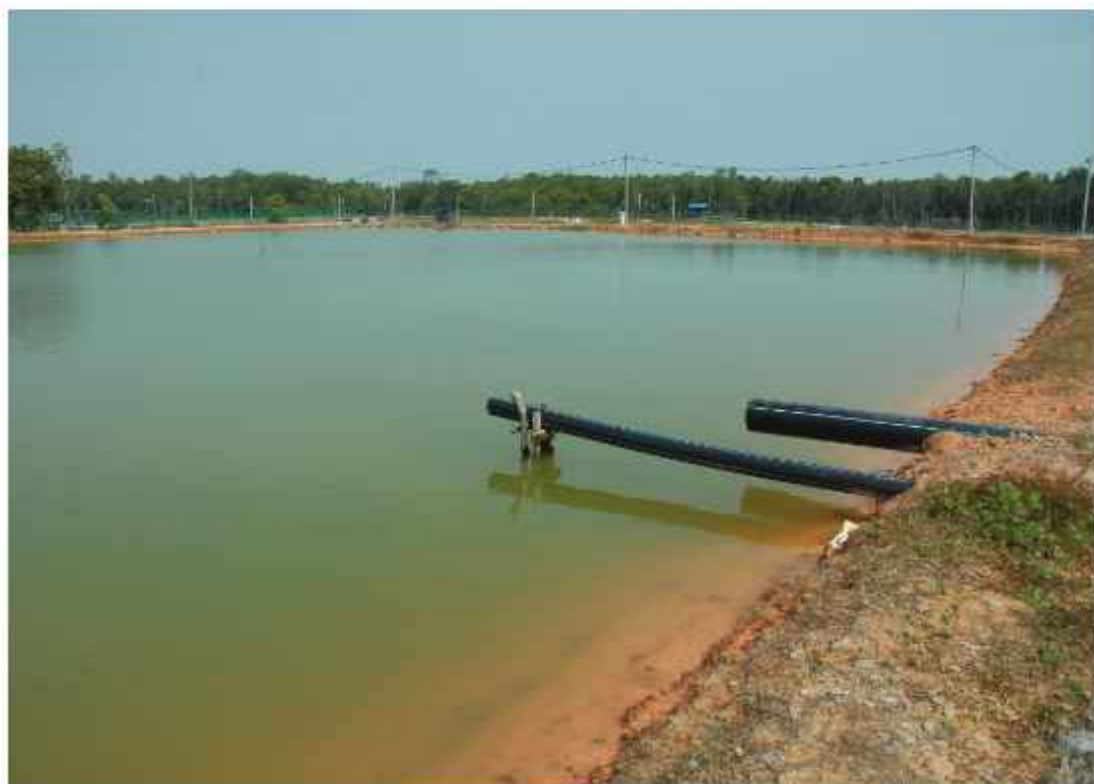
Foto 6 : Sistem air masuk menggantikan pintu air
