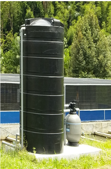
Gambar 1: Penapis pasir yang digunakan untuk menapis partikel kasar sebelum dimasukkan ke dalam tangki simpanan.
