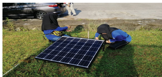
Rajah 4: Kerja-karya pemasangan panel solar di kawasan terbuka ruang kajian
