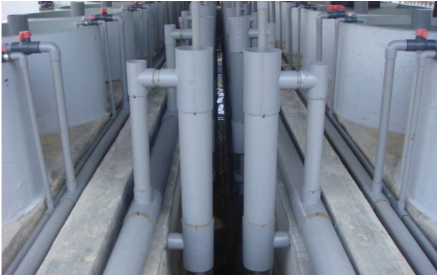
Rajah 1: Kedudukan waste-trap yang dipasang sistem asuhan benih CENTS-RAS
