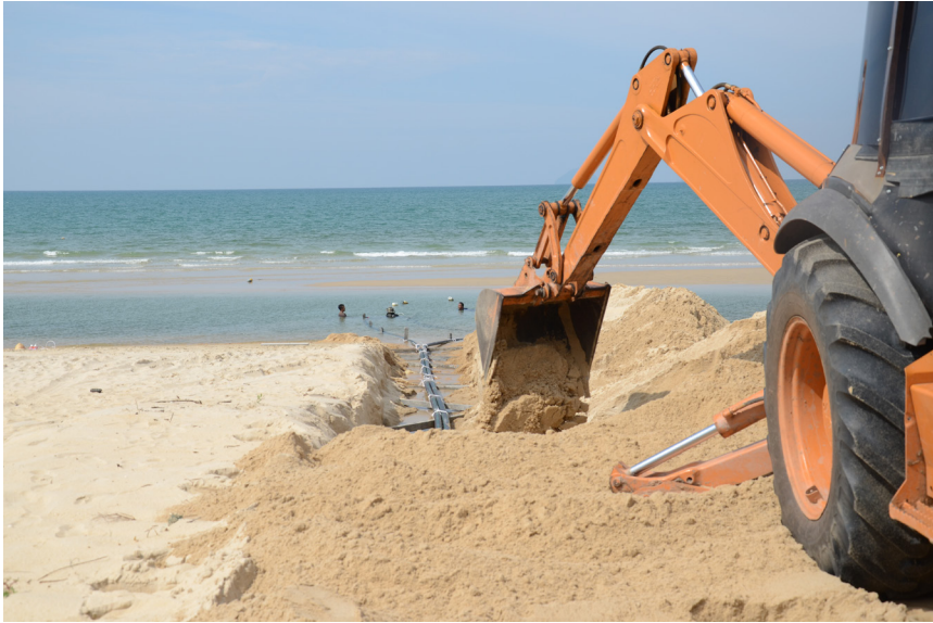
Pembinaan sistem saliran air laut
