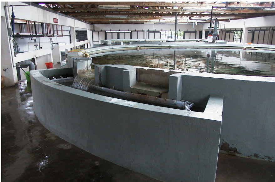
Tangki induk dan tangki pungutan telur secara aliran terus
